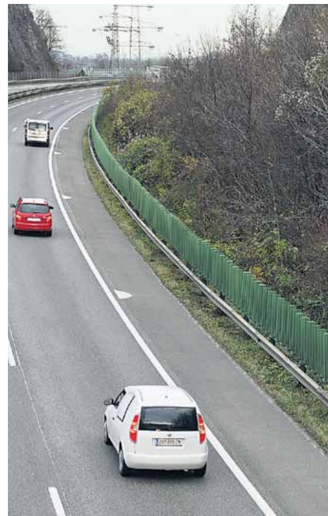
Blendschutz-Lamellen bei der Autobahn Höhe Koblach.
